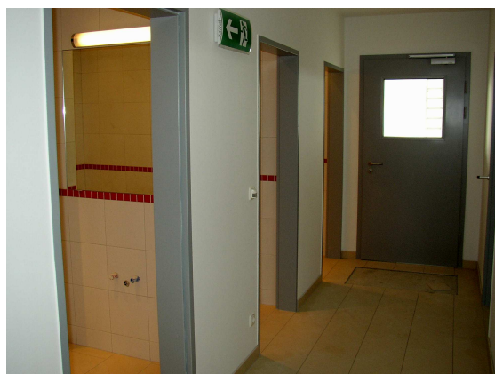
im Bild: die Eingänge in die sanitären Anlagen
