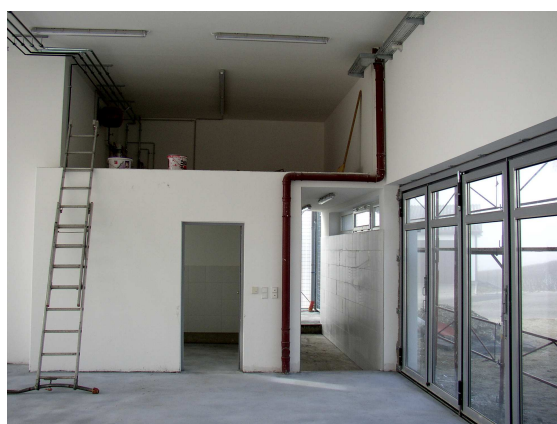
Blick in den Schlauchturm
