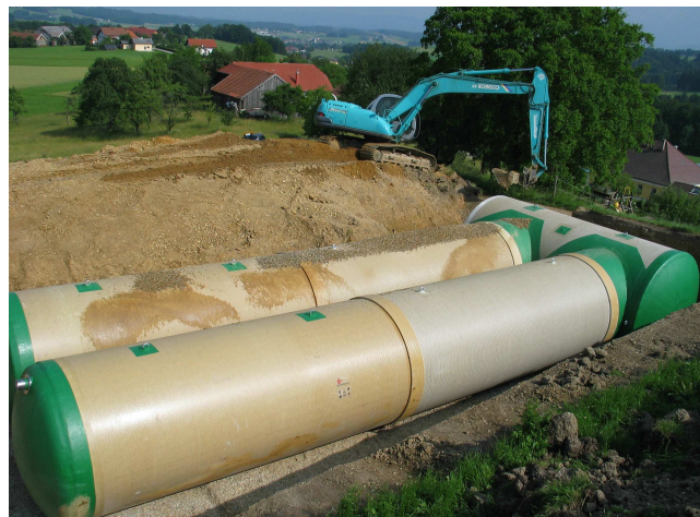
Im Bild die Hochbehälter in Otzigen
