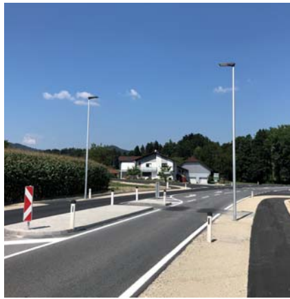
Der neue Fahrbahnteiler in Lessigen
