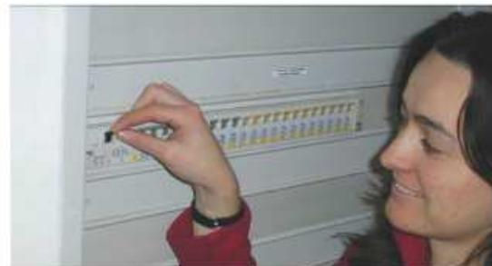
Alle Fehlerstromschutzschalter sind mit einer Prüftaste ausgestattet, die einen Funktionstest erlaubt.
