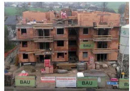
Die Robbauarbeiten am neuen GSG-Bau schreiten zügig voran.
