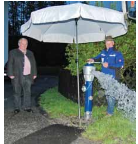
Bild: Alt-Bgm. Franz Sieberer und Wasserwart Gerhard Huemer nahmen die neue Wasserleitung in Unterhasel- bach im Rahmen einer Maiandacht offiziell in Betrieb.
