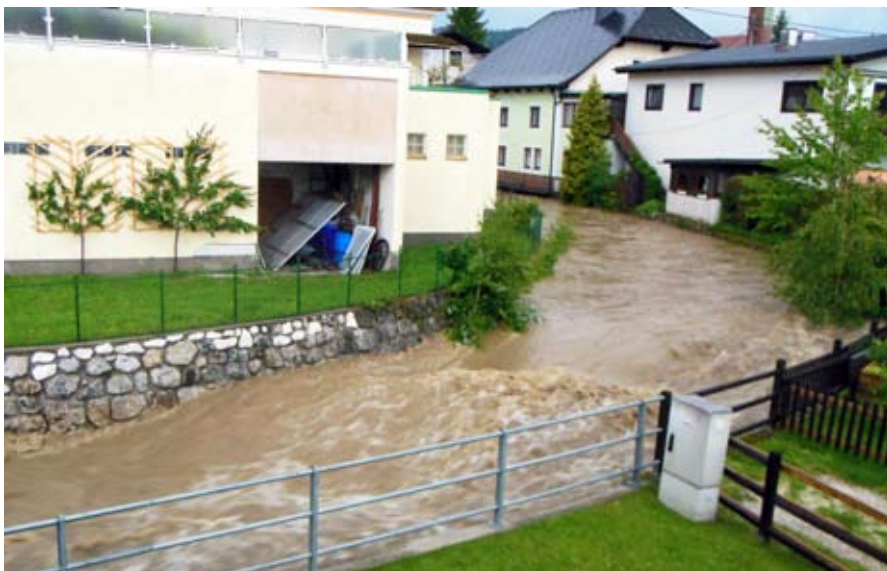
Hochwasser am 9. Juni 2013 am Zusammenfluss von Haselbach und Redl. Die eingebauten Soblschwellen konnten die Wassermassen fassen. In nur 20 Minuten fielen 57,7 Liter Regen pro m 2 .
