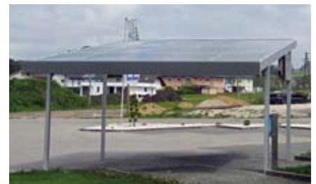
Solarcarport mit Stromtankstelle. Gesehen bei Pöllmann in der Haselbachstraße.
